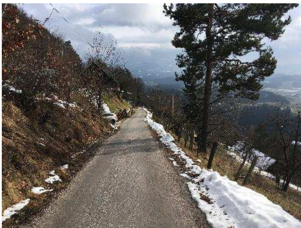
Slika 7: Pogled na plaz
