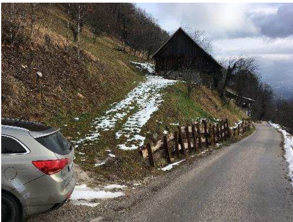
Slika 8: Pogled na plaz
