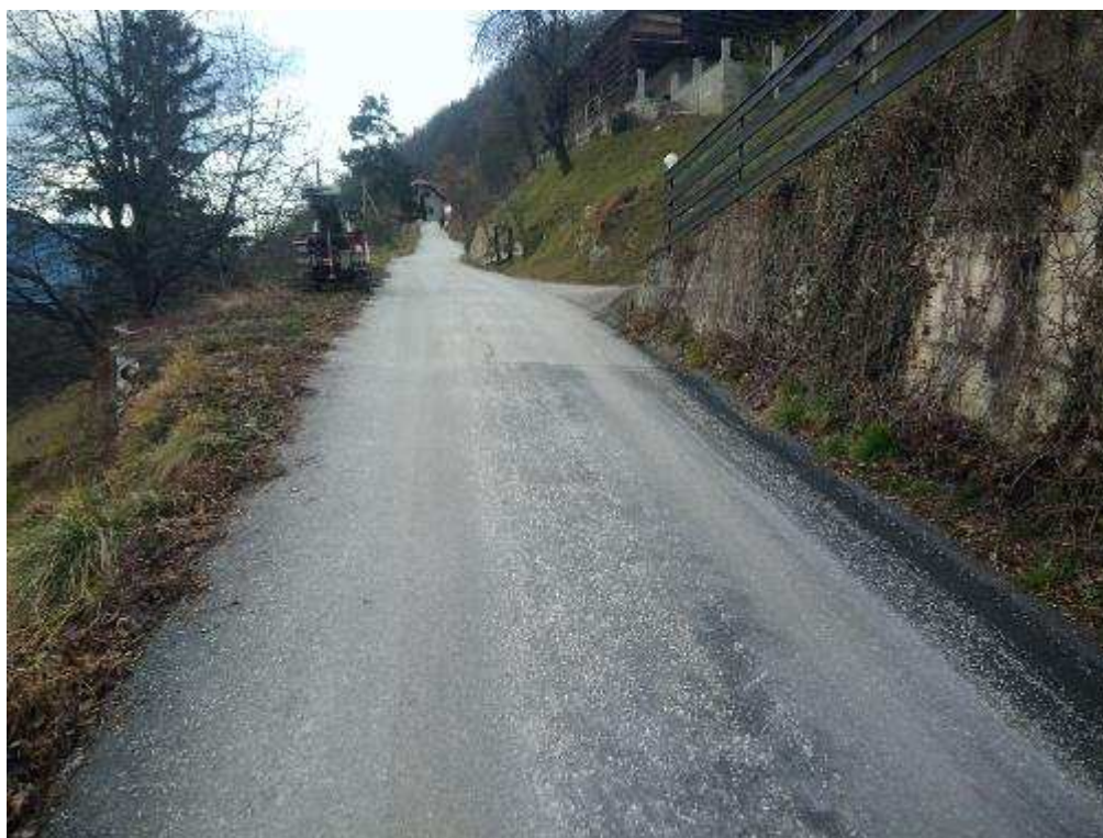
Slika 6: Pogled na plaz
